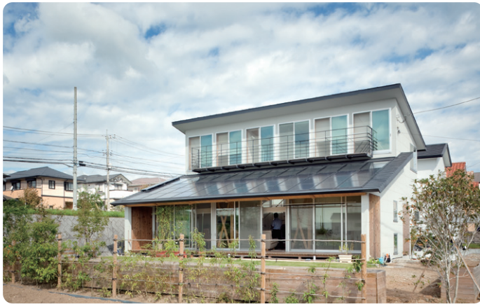
太陽を独り占めするように南向きの窓が並ぶY邸。1階屋根は太陽光発電パネルの効率を、2階屋根は窓からより多くの光を得られるように考えて、それぞれ角度が決められた
