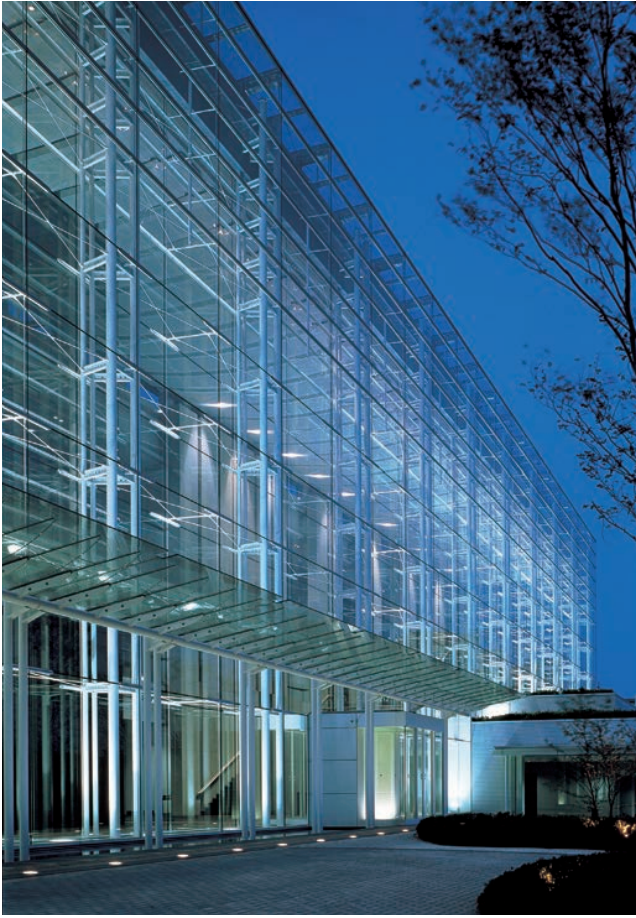
東葛テクノプラザ（千葉県・柏市） [日本板硝子：プレーナー・フィッティング・システム カタログより]
