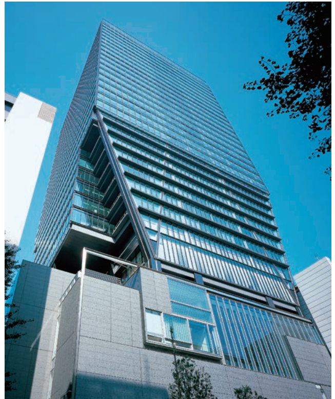
新東京サンケイビル（東京都・千代田区） [セントラル硝子：板ガラス総合カタログ（商品編）より]
