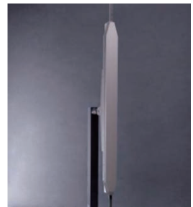
ガラスを部分的に支持する構法② ガラスのエッジを部分フレームにより支持する構法
